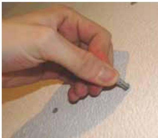
**Ilustración 4-3: Colocación de las espigas**
