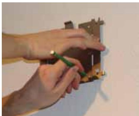
**Ilustración 4-1: Ejemplo para el marcado de los taladros**
